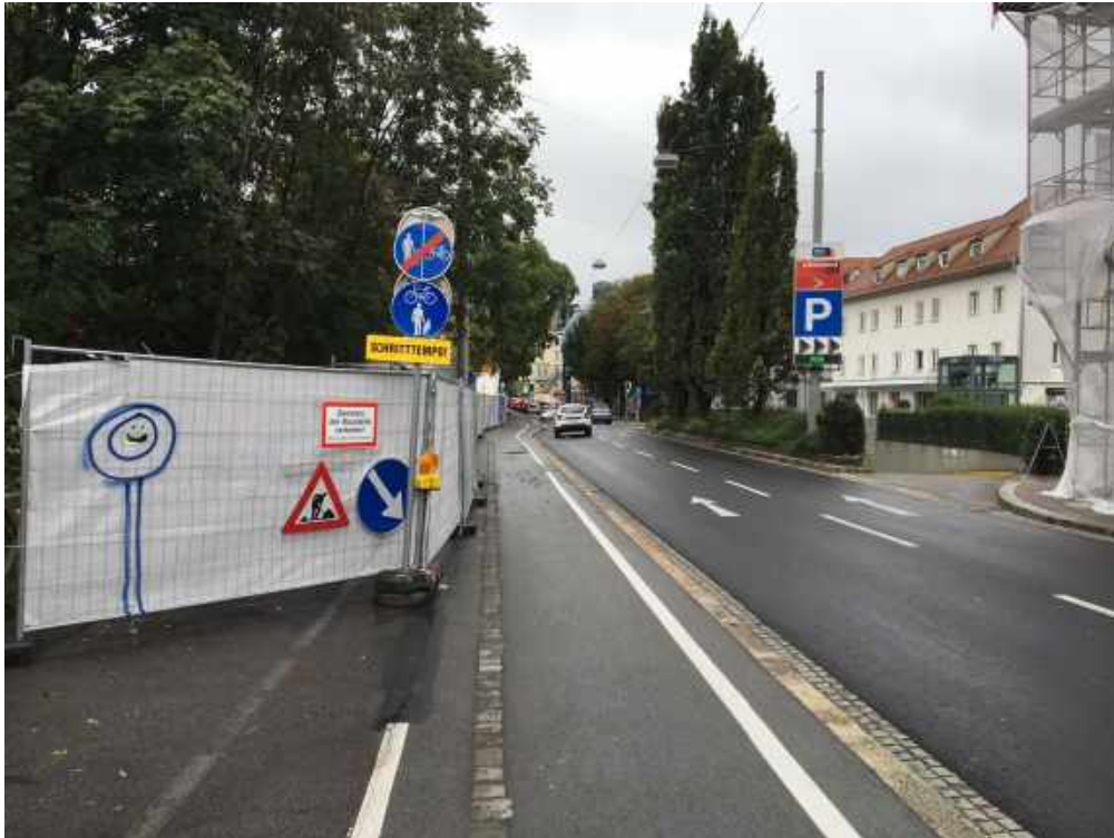
Der „Geh- und Radweg“ am Lendkai (Breite: 1,70 Meter)...
